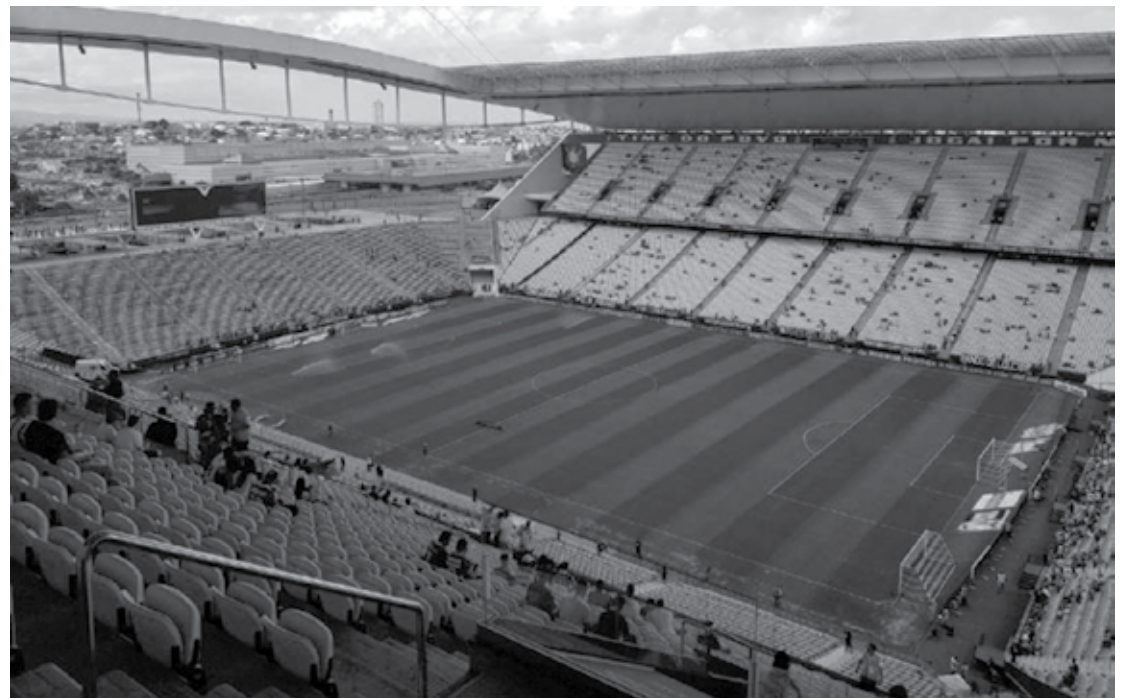
Notificação extrajudicial cobra dívida do Corinthians no valor de R$ 500 milhões pelas obras na Arena de Itaquera
